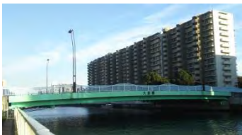
大富橋の全景
